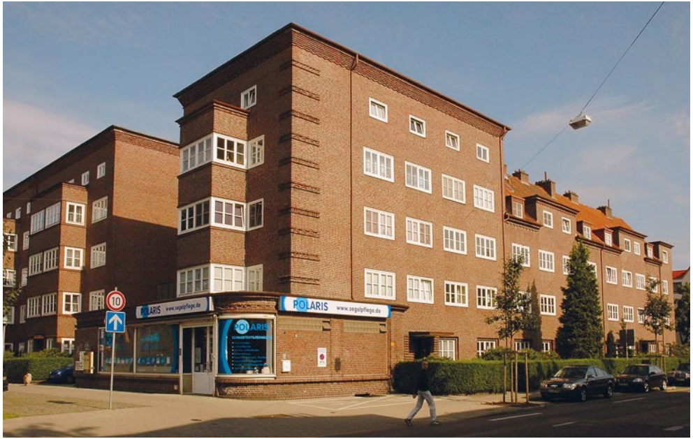
Wohnanlage des Gemeinnützigen Beamten-Wohnungsvereins, Hamburger Straße 222-240
