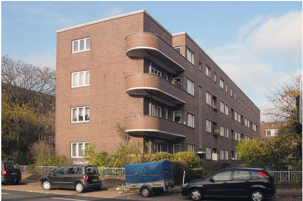
Einer der Blocks der AfA-Wohnanlage, Bismarckstraße
