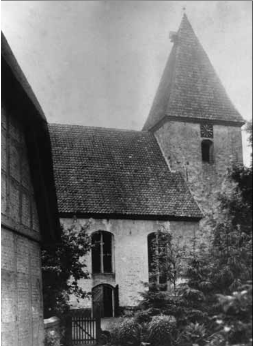
Die Felssteinkirche in Hambergen
